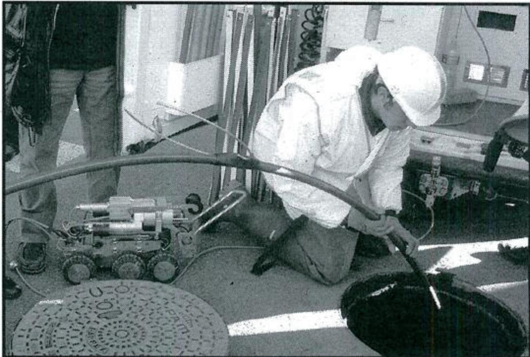
Le robot se chargera de placer la gaine en haut de la canalisation.
